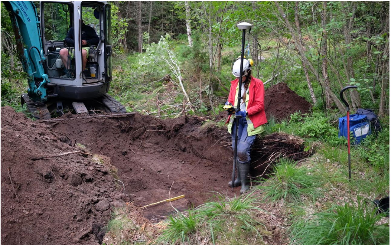
Illustration 13. Schakt 16 togs upp i den äldre vägbanken. Linda mäter in. Foto mot söder.
