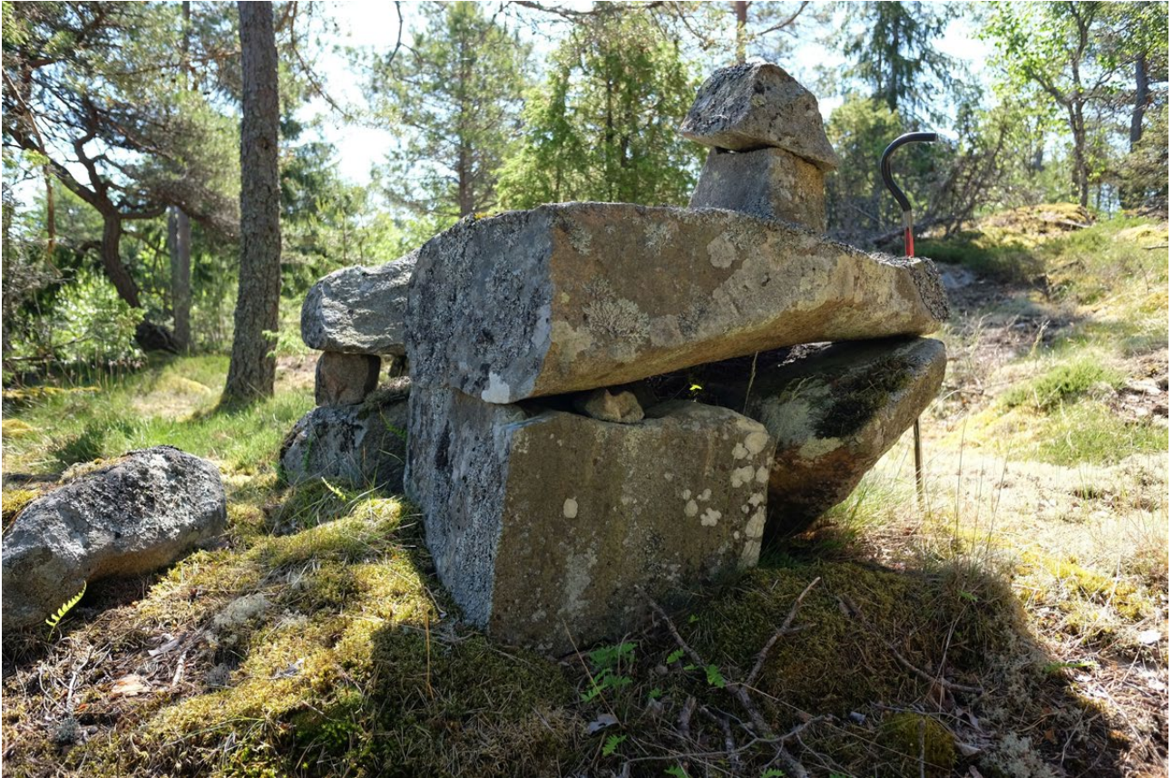
Illustration 11. I det lilla stenbrottet L2021:3943 fanns denna märkliga konstruktion, uppbyggd av block med rundkilsmärken. Foto mot sydost.
