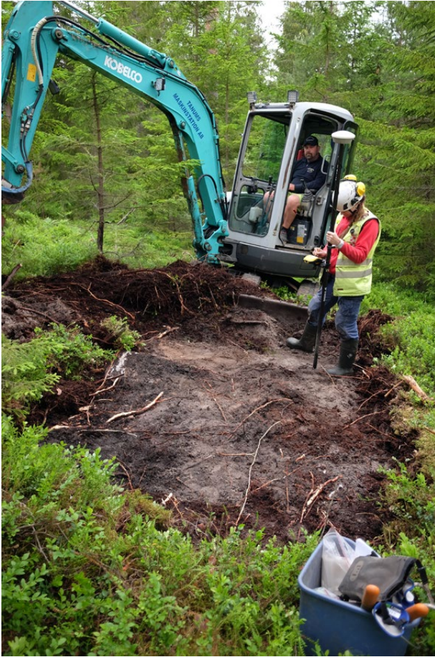
Illustration 3. Linda mäter in schakt 12 inom nyregistrerade L2021:3945. Foto mot nordväst.
