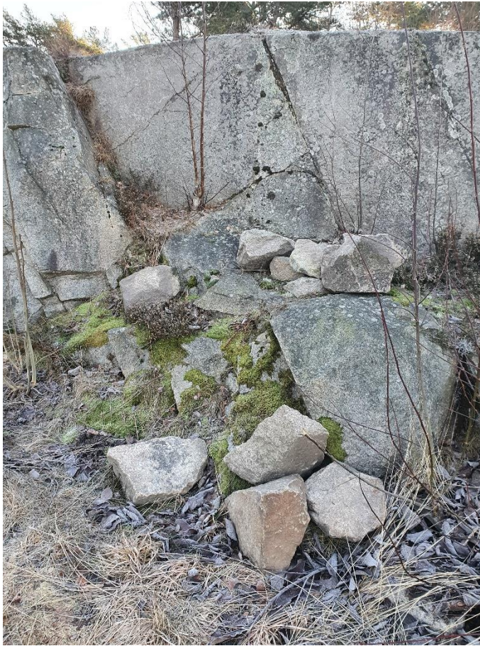
Figur 3.3.6. Detalj av skärningen längs Tornstigen, med ditlagda block.
