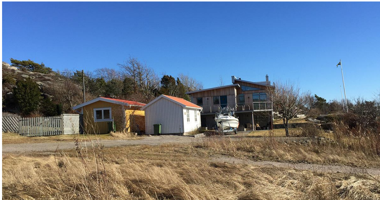
Exempel på komplementbyggnader placerade i fastighetsgräns med små avstånd till varandra
