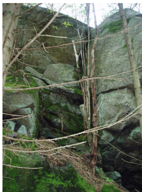
Foto 18. Slänt instabil mot öster
