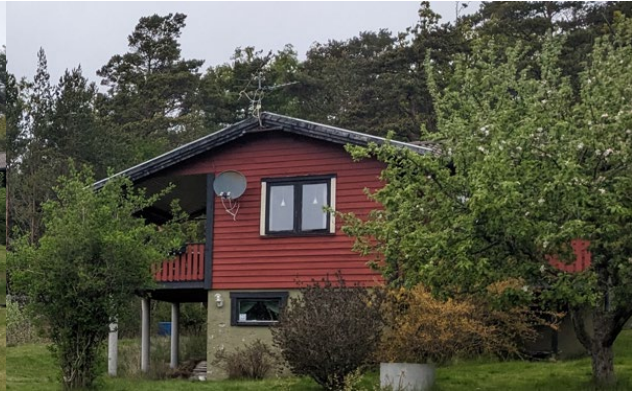
Befintlig huvudbyggnad Kecal 1:122
