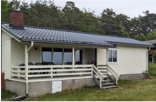
Befintlig huvudbyggnad Kecal 1:121
