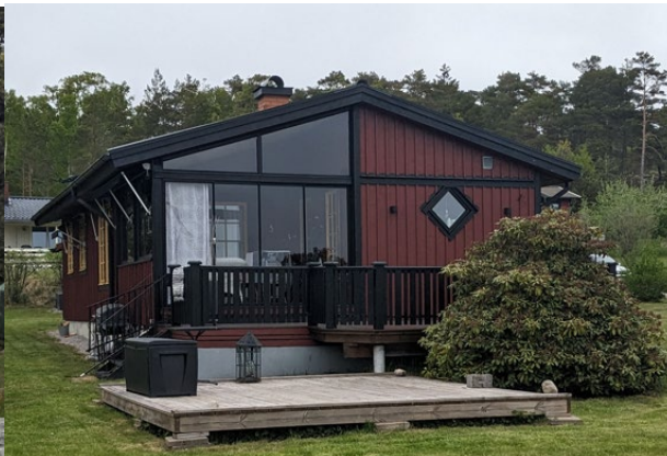
Befintlig huvudbyggnad Kecal 1:120
