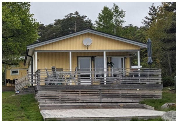
Befintlig huvudbyggnad Kecal 1:18
