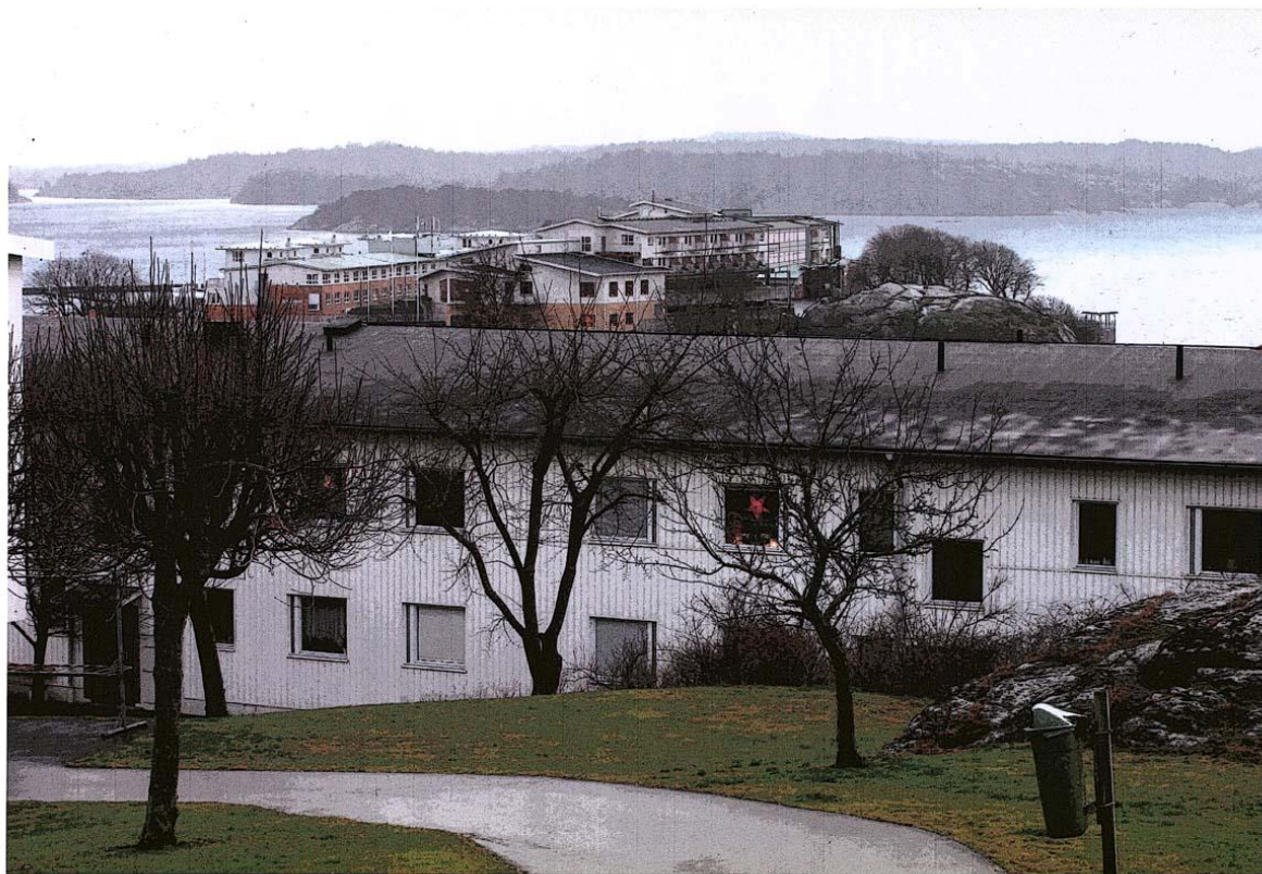
Före och efter tillbyggnad
