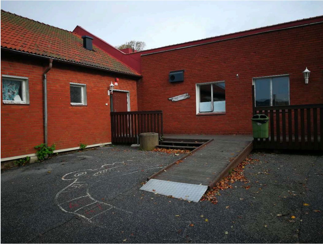
Foto 3. Visar utvärdig fasad, foto i riktning mot norr.
