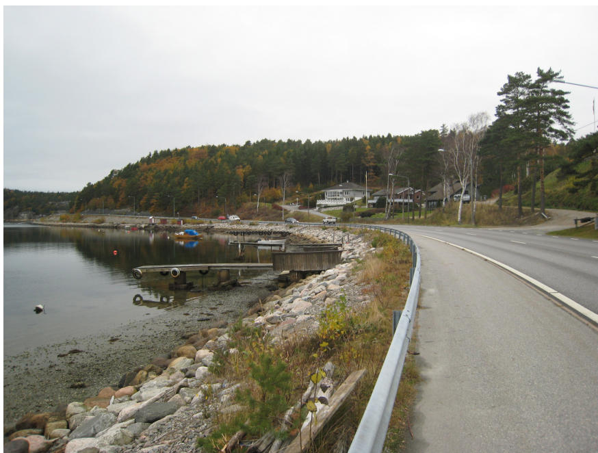
Foto 2. Del av Starekilen, med strandskoning av sprängstensblock
