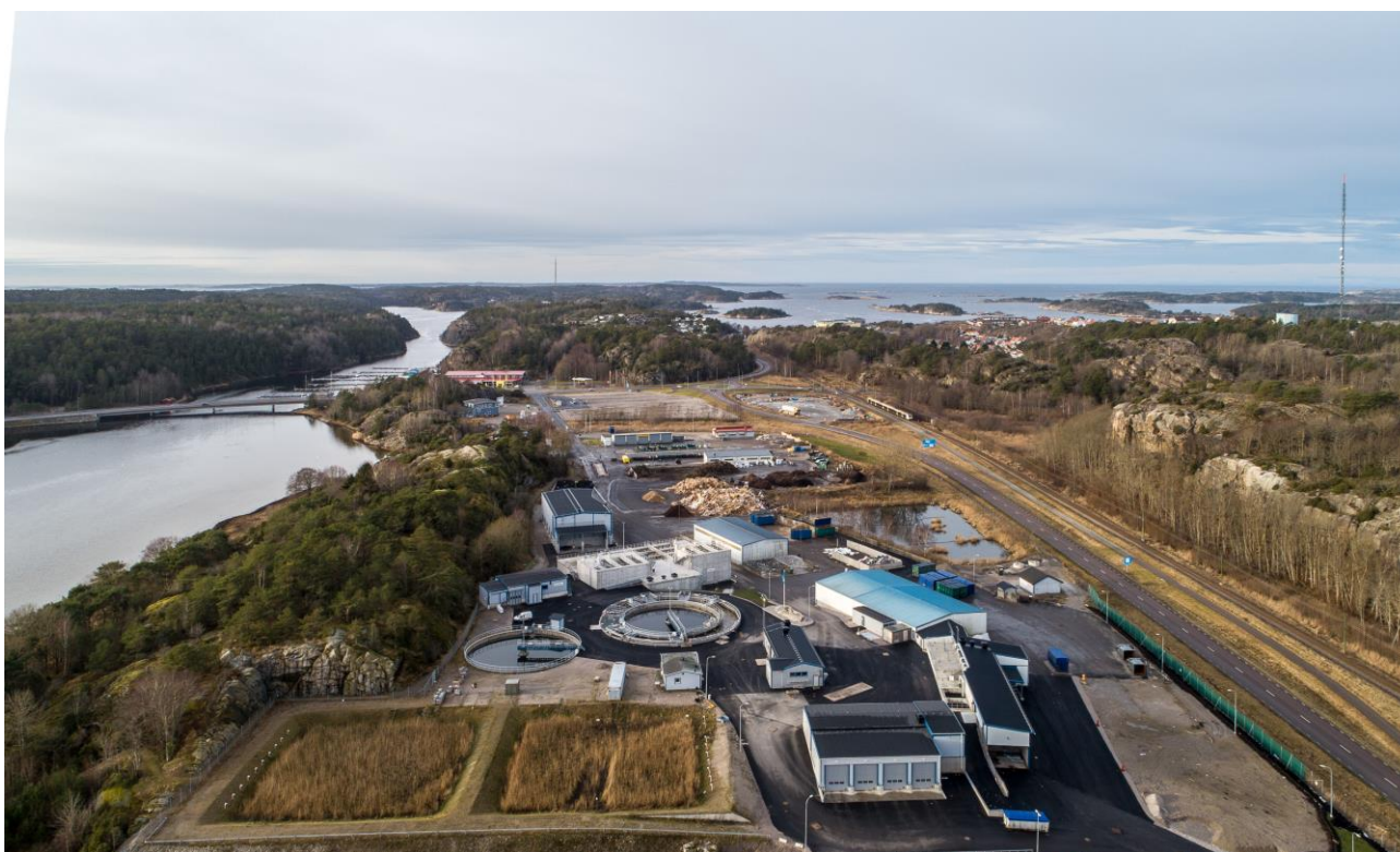
Bild: Österröds avloppsreningsverk
